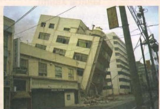
Последствия землетрясения в Кобе (Япония) 1995 г.
